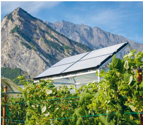
Les panneaux Insolight résolvent ce problème, en combinant haut rendement et translucidité. La technologie optique permet à la fois de récupérer la lumière directe avec 29 % de rendement tout en laissant passer la lumière diffuse souhaitable pour la photosynthèse.
